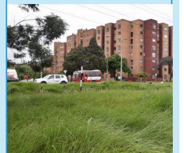
Obra en construcción ubicada en la Avenida Ciudad de Cali por Avenida Ferrocarril de Occidente.
