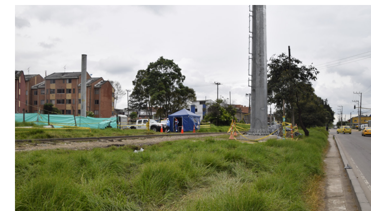
Obra sin iniciar construcción en la Avenida Ferrocarril de Carrera 93 a Carrera 100.
